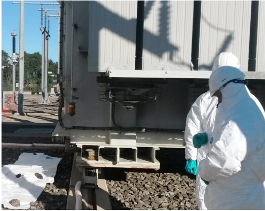
Dos operaris d'Endesa treballant a la subestació Empordanet Foto: IMATGE CEDIDA PER ENDESA.
