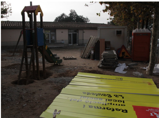
El cos de nova construcció ocuparà part de la zona de jocs infantils que fins ara hi havia a tocar del local social de la Sauleda Foto: E.A.
