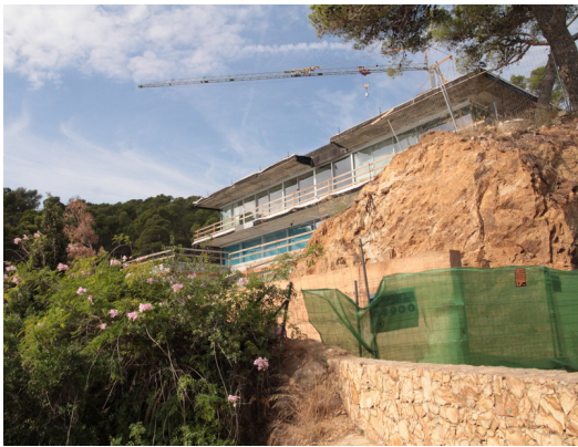
Les obres del xalet del Golfet, aquest octubre Foto: E.A.
