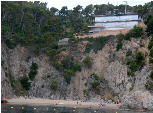
El xalet que s'està fent sobre El Golfet, en una imatge des del mar Foto: PACO DALMAU.
