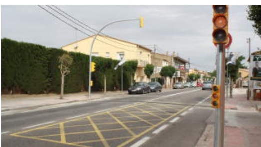
Els dos nous semàfors instal·lats a la travessera de Llofriu · DdG
