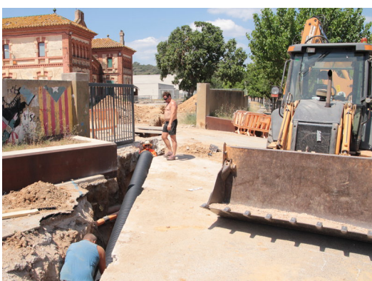
Els operaris de la brigada de Palafrugell, instal·lant el tub ahir amb l'escorxador al fons Foto: E.A.
