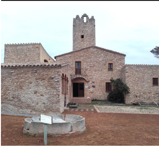
L'exterior del Mas d'en Pinc de Begur, que ja s'ha acabat de rehabilitar Foto: EL PUNT AVUI.
