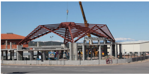
L'estructura del sostre de la mesquita, ahir, en fase d'assentament sobre els pilars Foto: E.A.
