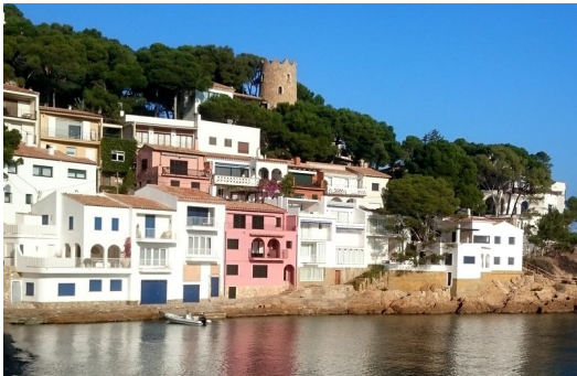
Divreses façanes de Sa Tuna han estat millorades i han rebut subvenció. Foto: EL PUNT AVUI.
