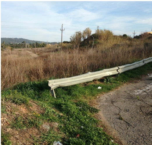
Espai del polígon on connectarà el vial que prové del l'avinguda Pompeu Fabra. Foto: J. PUNTÍ.
