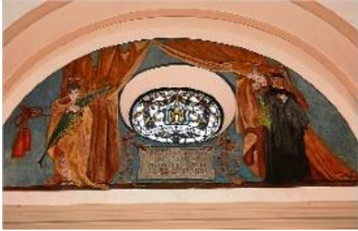
Part de les pintures d'un ull de bou de l'església que s'han restaurat.
