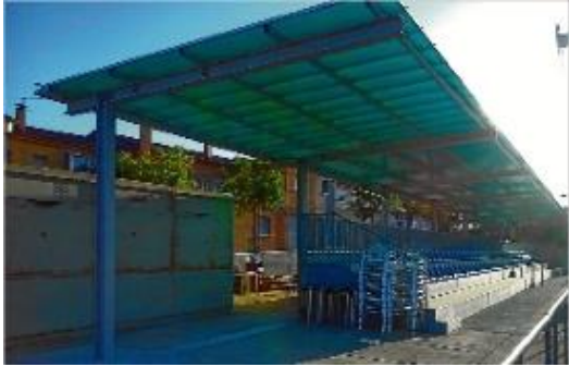
La coberta que s'ha instal·lat al camp de futbol.
