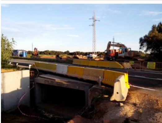
Les obres ja no dificulta l'accés de vehicles a la zona de la Fanga a Palafrugell. Foto: EL PUNT AVUI.
