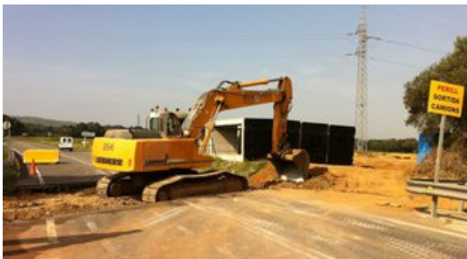
Les màquines ja treballaven ahir al migdia en la carretera d'accés a Palafrugell. Foto: JOAN PUNTÍ.
