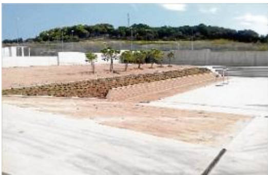
Al Piverd, s'ha construït un mur de contenció a la pista esportiva.
