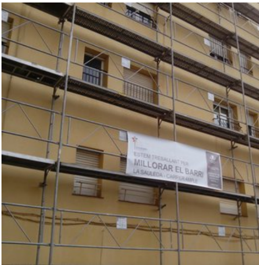
La bastida que cobreix una de les façanes que s'estan rehabilitant Foto: EL PUNT AVUI.
