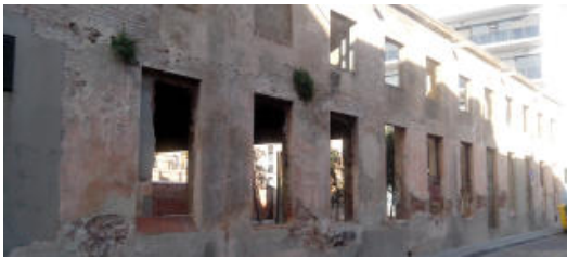
Palafrugell reformarà les façanes i l'estructura de la Bòbila Vella
