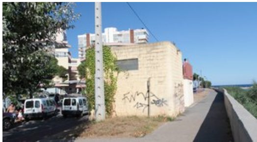
Transformador a l'avinguda de Madrid de Platja d'Aro, on s'ha modernitzat la xarxa Foto: E.A.
