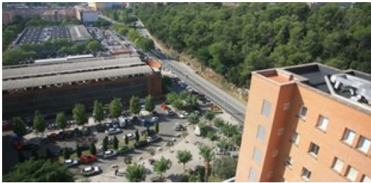
Vista de la zona on, segons el projecte originari del tripartit, havia de construir-se el nou Trueta, just davant de l'actual. Foto: MANEL LLADÓ.
