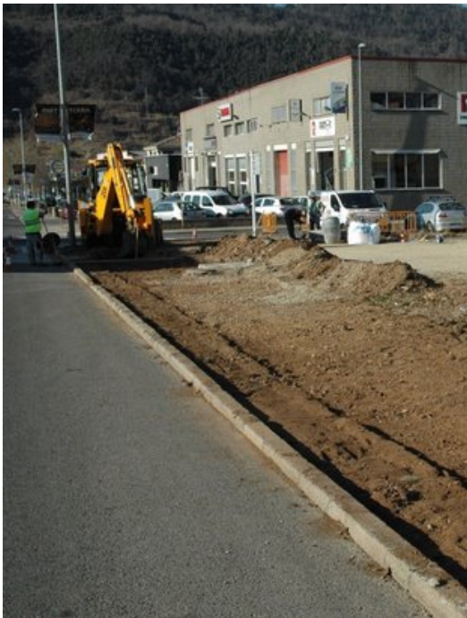
Un detall dels treballs que s'han començat a executar a la vorera de l'accés nord al centre de la ciutat. Foto: J.C.
