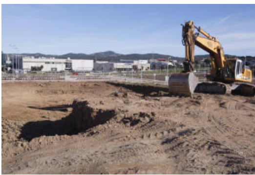
Una excavadora aturada, aquest dijous, en els terrenys del complex.<br/>
