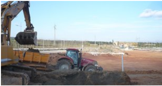
la retroexcavadora que va rebaixant els terrenys del complex lúdic i comercial, ahir al migdia. Foto: A.V.
