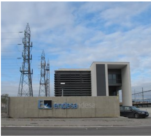
La subestació de Salt fins on haurà d'arribar la línia d'alta tensió de 132 Kv Foto: J.N.
