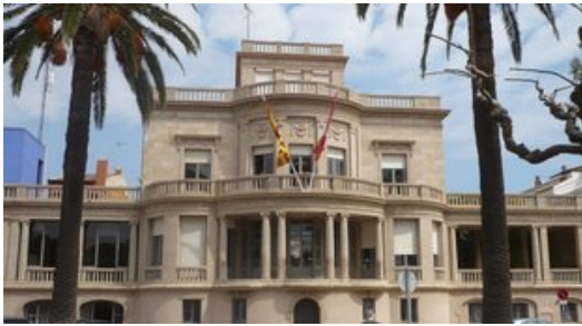
L'edifici de l'ajuntament de Palafrugell, un dels immobles que formen part del lot del servei de neteja. Foto: A.V.
