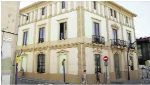
L'edifici de Cal Ganxó.<br/>
