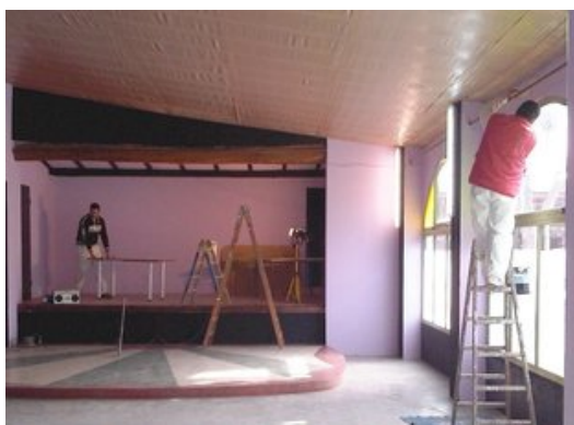
La brigada de pintura que està actuant en diversos edificis municipals. Foto: A.V.
