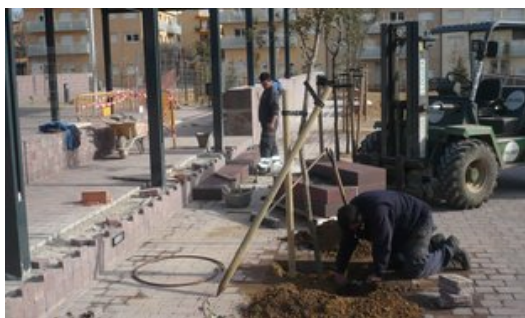
Dos treballadors enllestit diverses obres pendents del parc urbà de la Sauleda. Foto: A.V.
