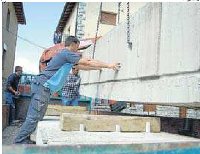
Uns operaris recullen una de les peces de formigó tallades del tronc
