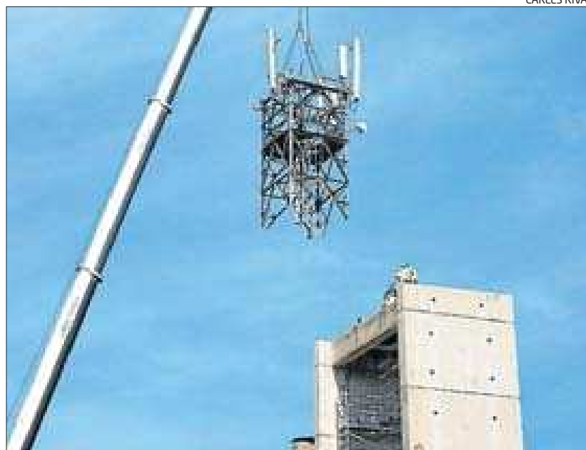
La grua treu l'antena metàl·lica de l'estructura de formigó i la retira
