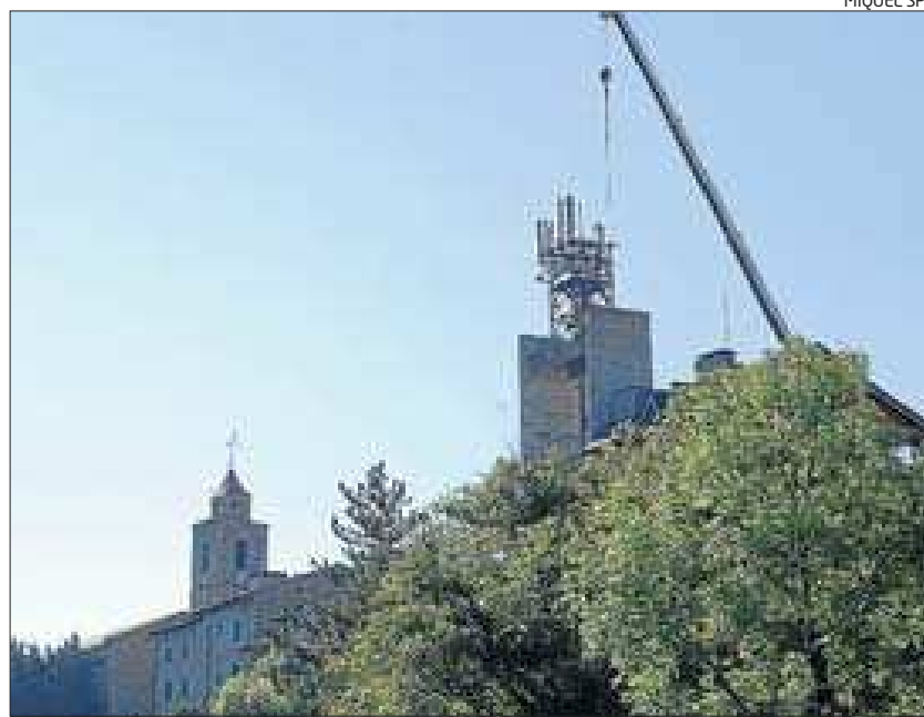
Una grua comença a subjectar peces per treure-les, a l'inici del procés
