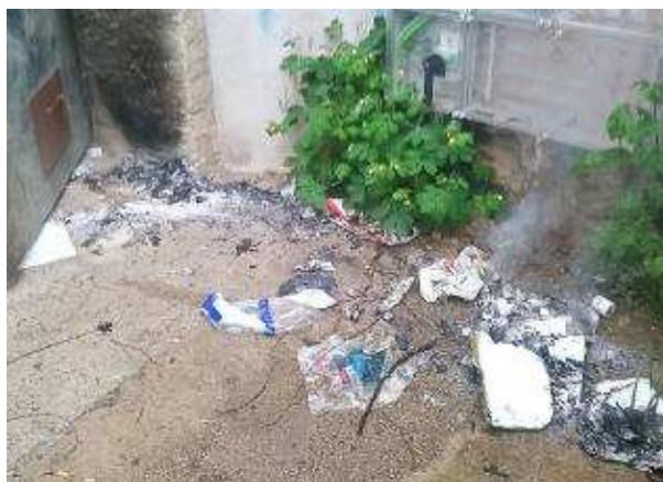
L'incendi es va originar per una crema al costat de la porta de calderes. acn
