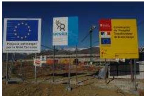
Les obres de construcció de l'Hospital Transfronterer.
