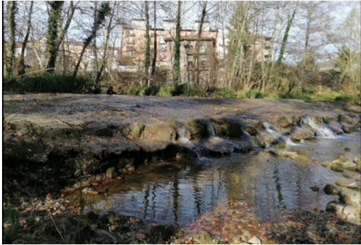
La resclosa de la central hidroelèctrica de Can Xons ACA.
