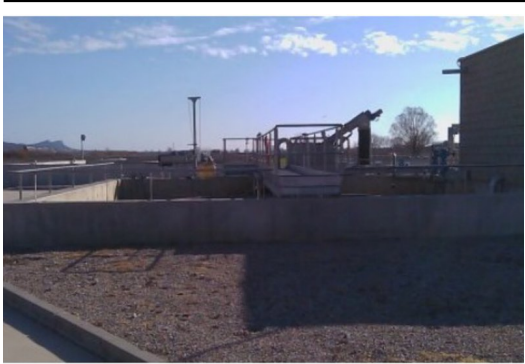
Adjudiquen les obres que connectaran Gualta amb la depuradora de Serra de Daró.
