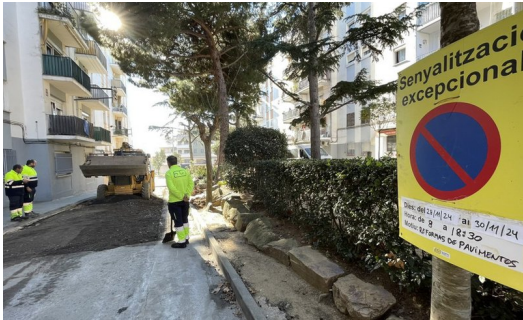
Els primers treballs d'asfaltatge que s'estan fent AJUNTAMENT DE BLANES.
