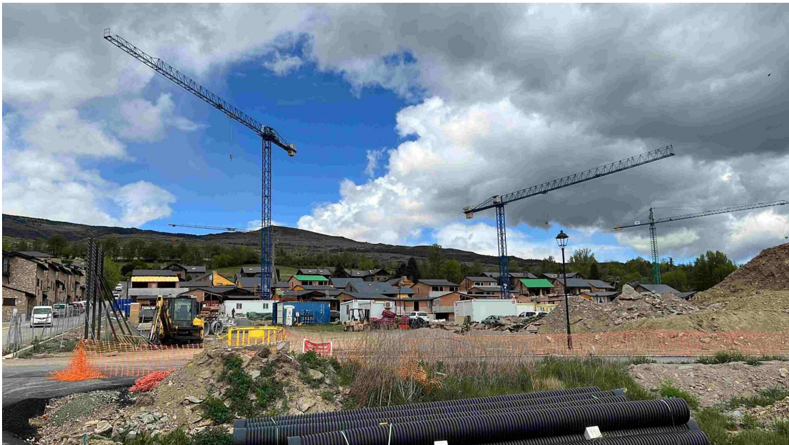
Construcció de diverses cases a Ger, a la Cerdanya / Albert Lijarcio
