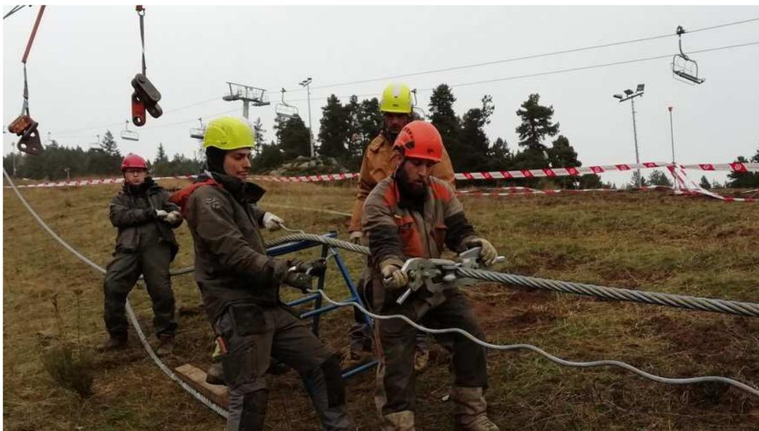
Opération délicate du détoronnage du câble porteur pour réaliser l'épissure.
