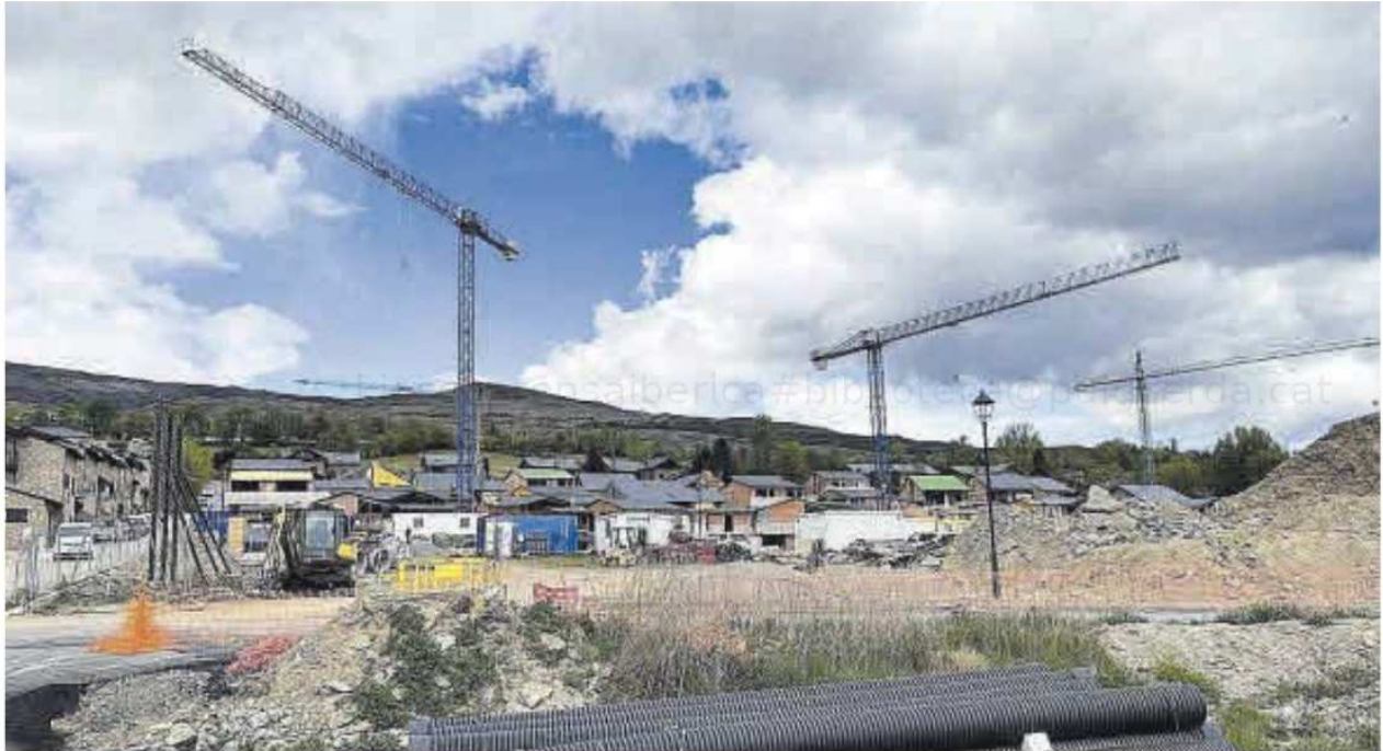
Construcció de diverses cases a Ger
