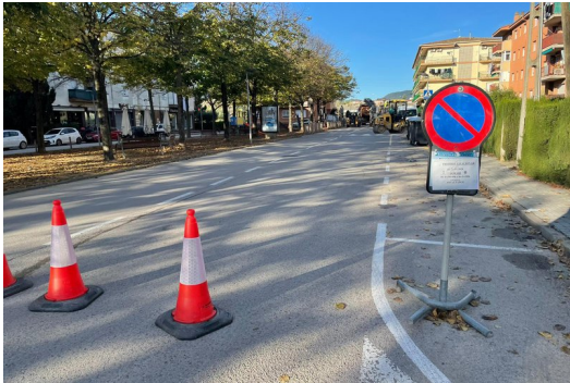
Inici dels treballs al carrer Figueres AJUNTAMENT DE BANYOLES.
