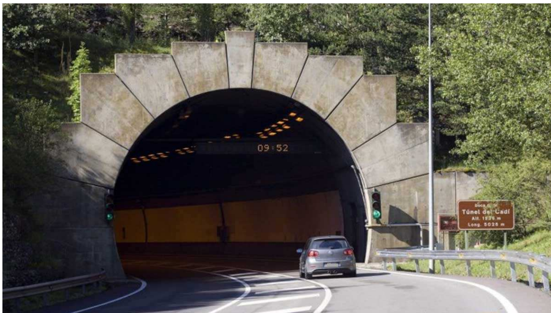
Vehicle accedint al Túnel del Cadí (Foto: Consell Comarcal de la Cerdanya).
