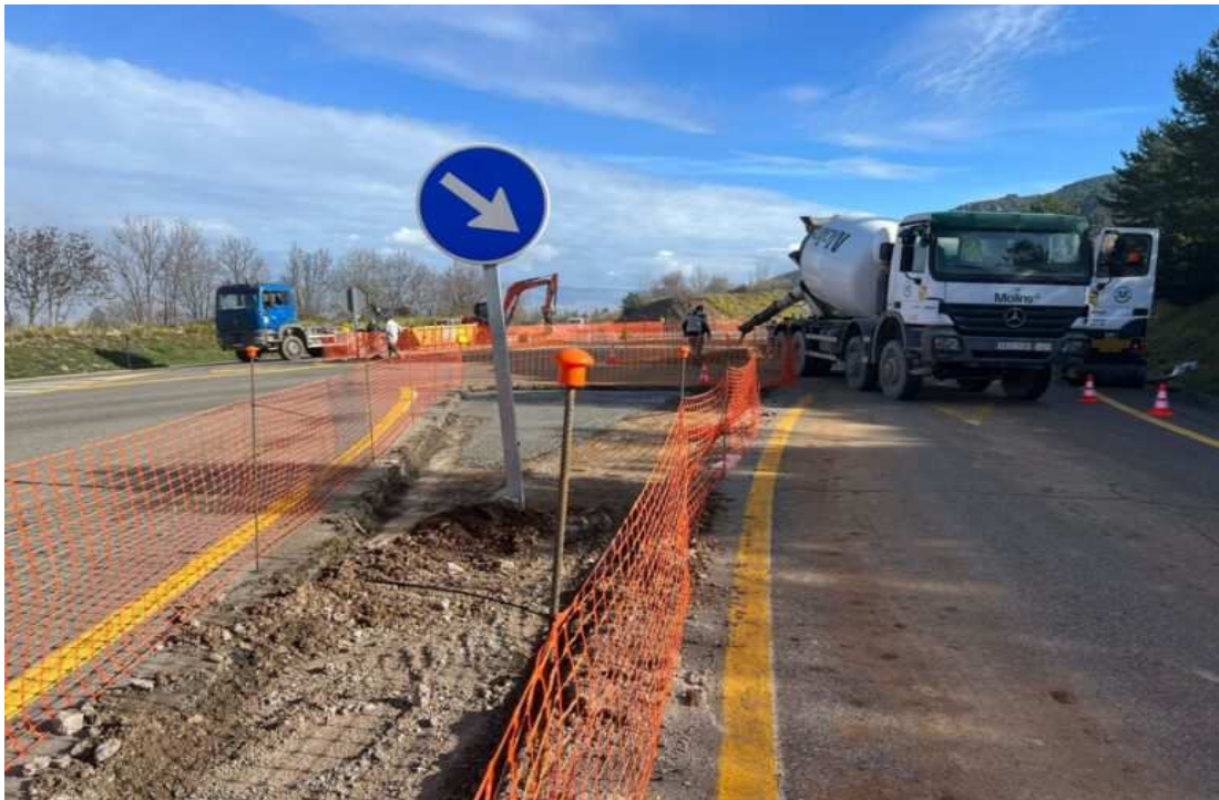
Construcció de la nova rotonda d'Urús./M.F.
