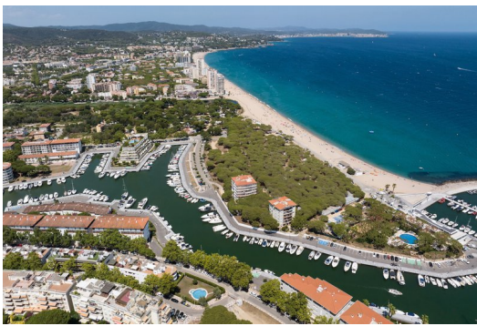
Imatge de la Marina de Port d'Aro SOS COSTA BRAVA.
