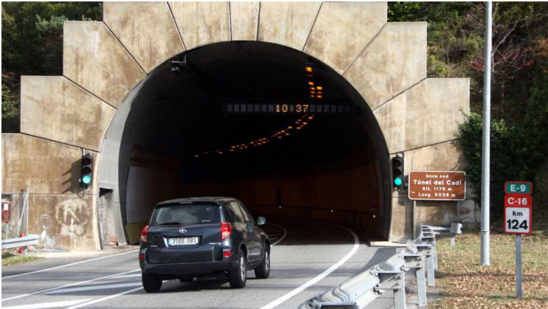
La boca sud del túnel del Cadí | ACN
