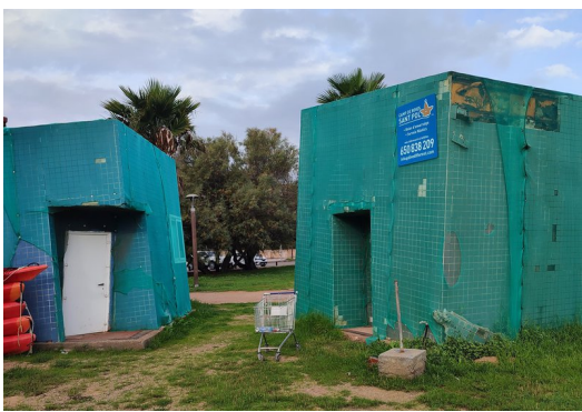
Els cubs, edificacions que es rehabilitaran E.A.
