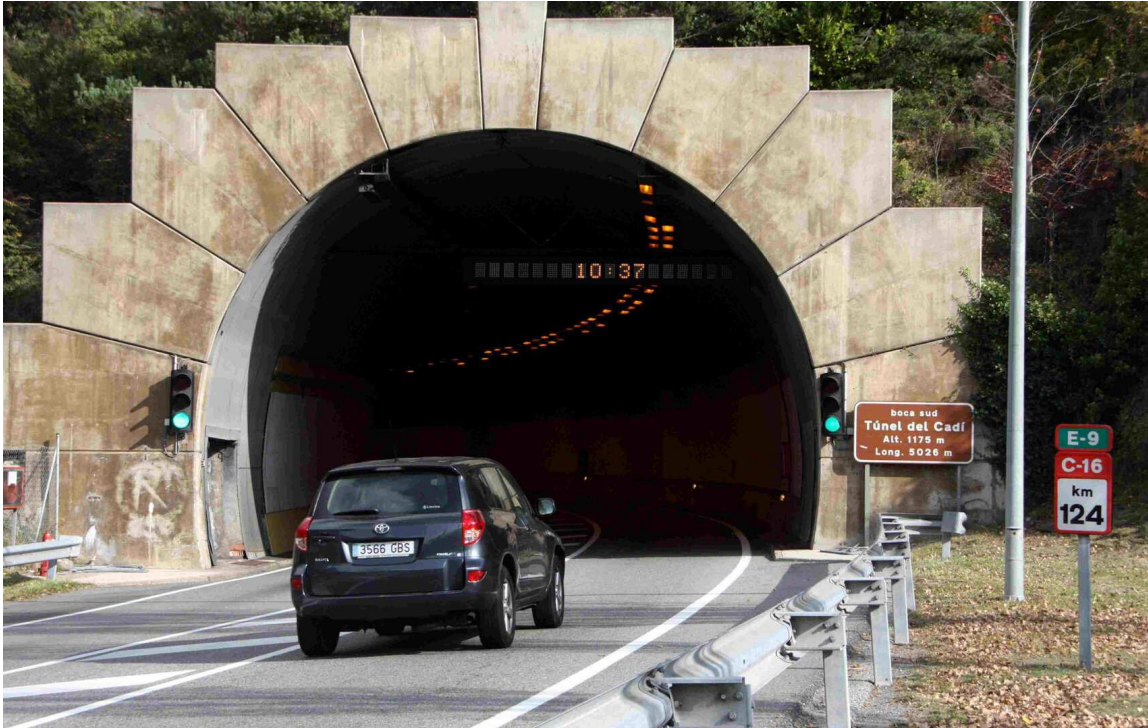
Un vehicle a la boca sud del túnel del Cadí, al Berguedà / ACN
