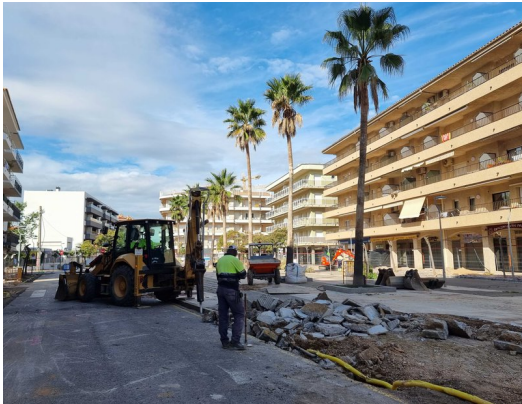
Comença la reurbanització de la plaça Catalunya i l'avinguda Costa Brava.
