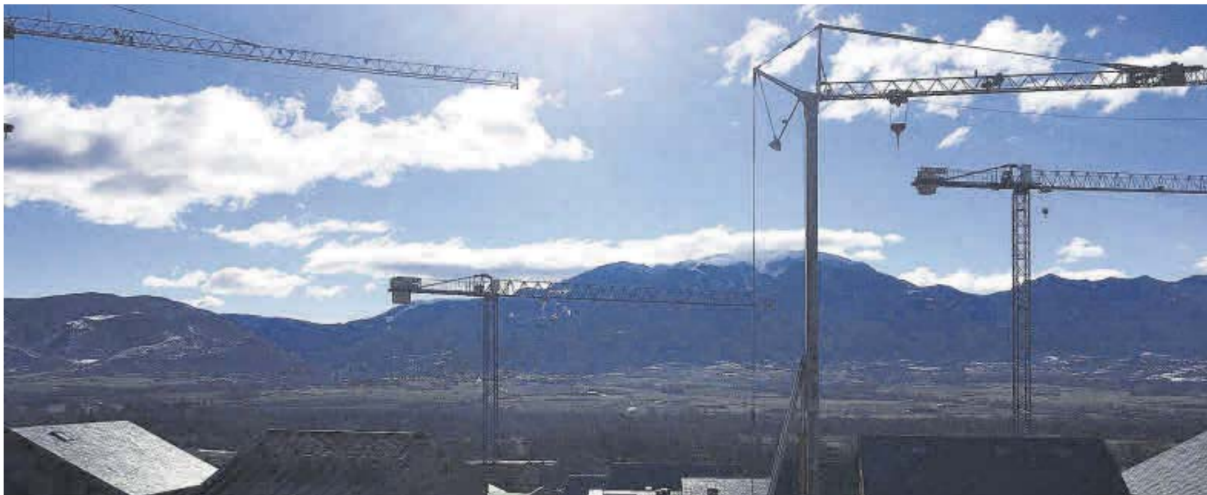
Grues de la construcció en una nova zona residencial de Cerdanya davant les pistes d'esquí de la Molina i Masella
