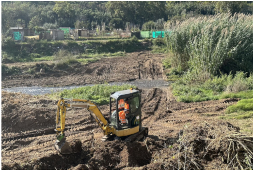
Una excavadora treballant al tram del Ripoll AJUNTAMENT DE SABADELL.
