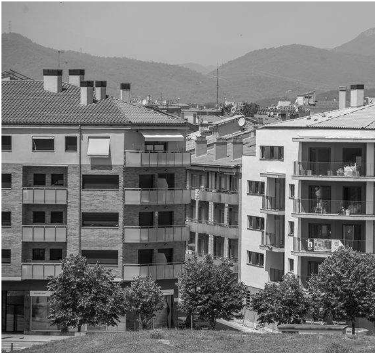
Blocs de pisos a Girona QUIM PUIG .
