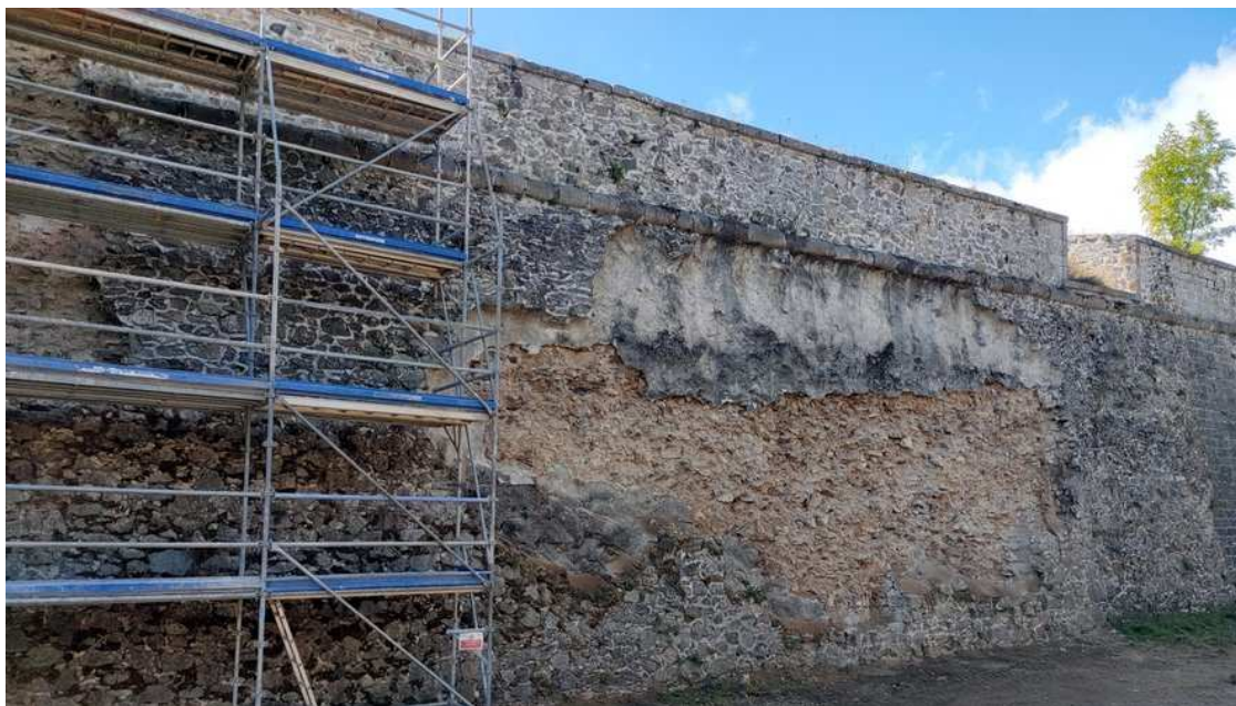
Restauration en cours du rempart Nord de la ville.
