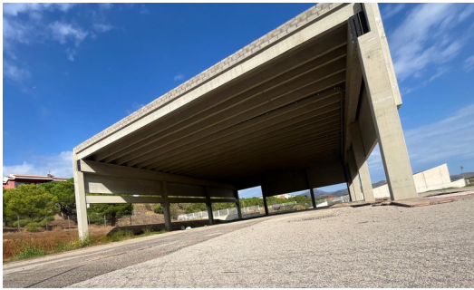
L'estructura del que serà el nou espai social i firal de Llançà J.T.
