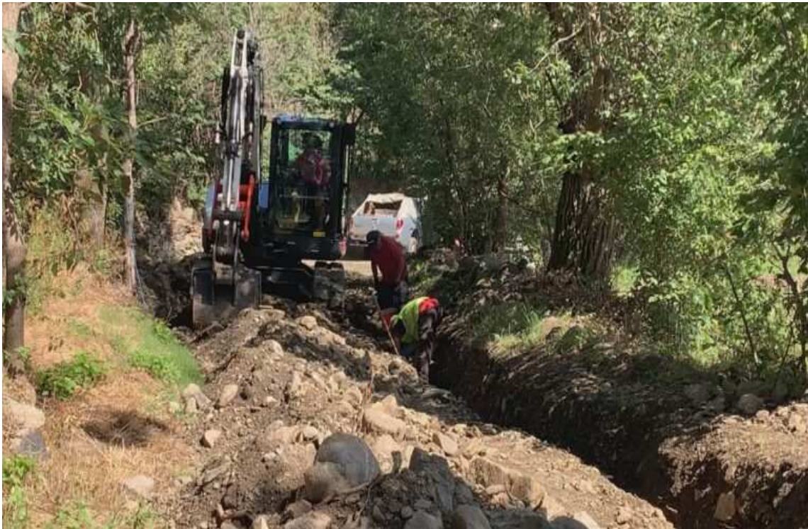
Obres de millora al camí vell de Cereja./M.F.
